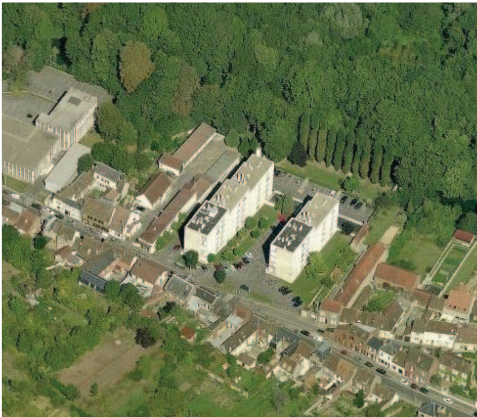
DES BÂTIMENTS EN PEIGNE LE LONG DES BOISEMENTS
