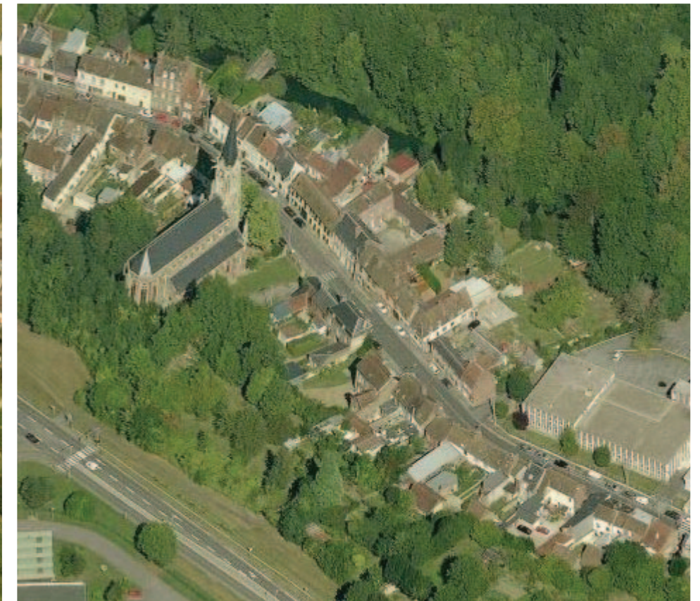
RUES TENUES PAR DES FAÇADES
